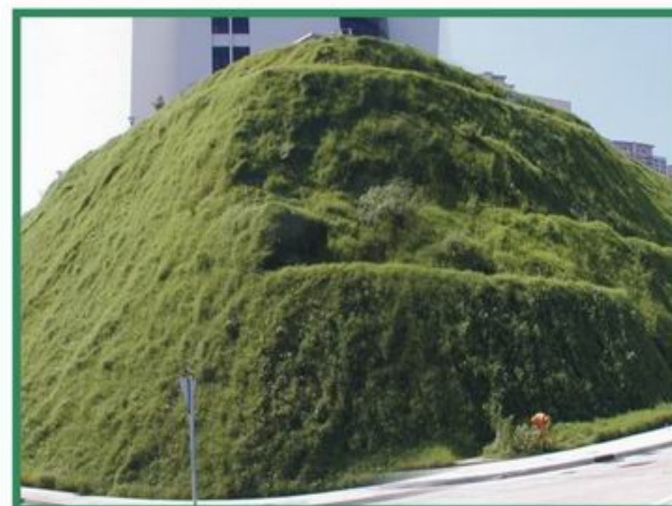
6. 三个月后整个斜坡已被绿化
