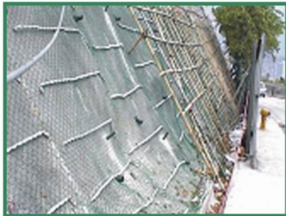
2. 草坪加固网、肥料条及疏水管延长管固定在斜坡上
