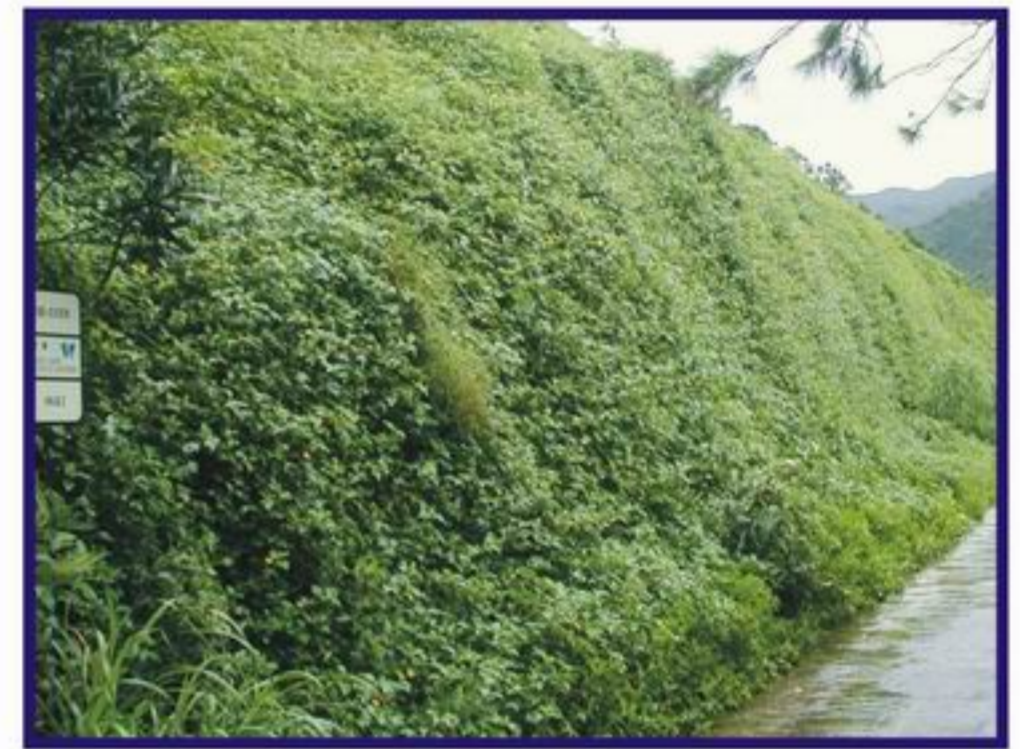
6. 三个月后整个斜坡已被绿化
