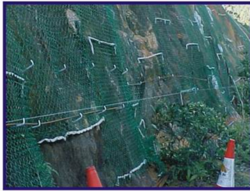
2. 用锚钉及钢筋固定带肥料条的草坪加固网
