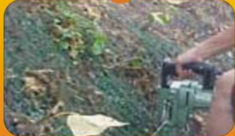
1、用工具钻造植生洞
