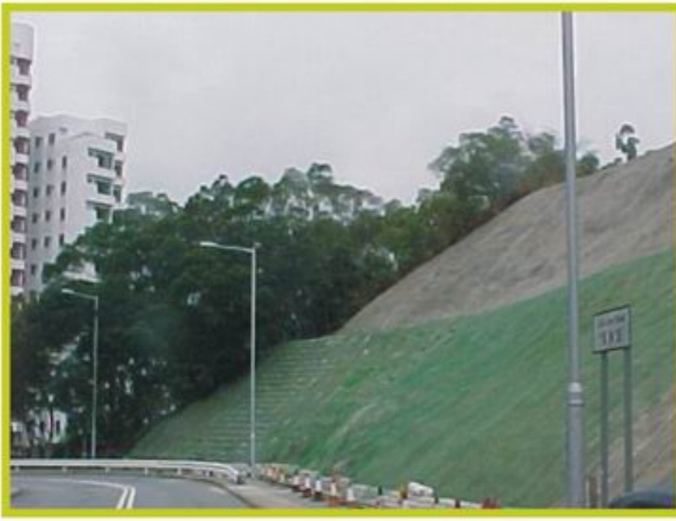
1. 用锚钉把草坪加固网固定在斜坡面
