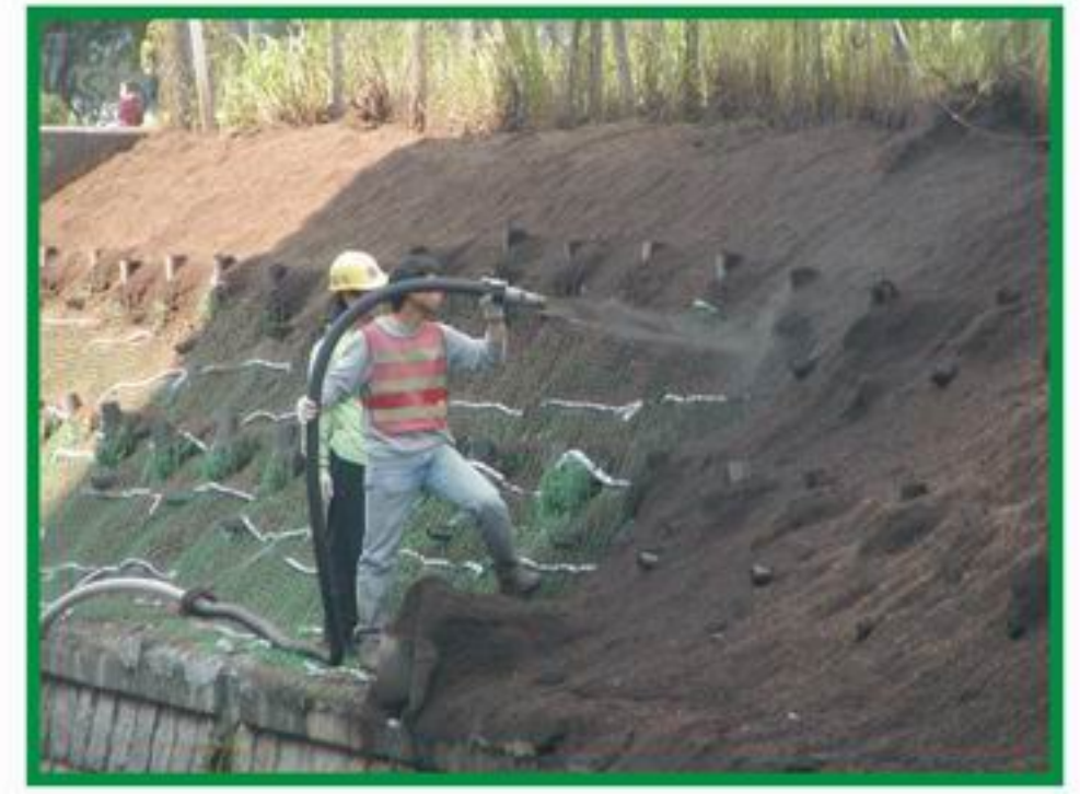
3. 基质土喷于斜坡面
