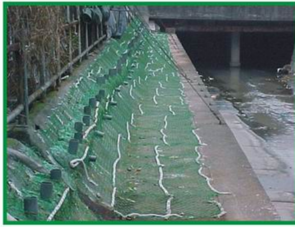
2. 草坪加固网、肥料条、植物种植管及疏水道延长管固定在斜坡上
